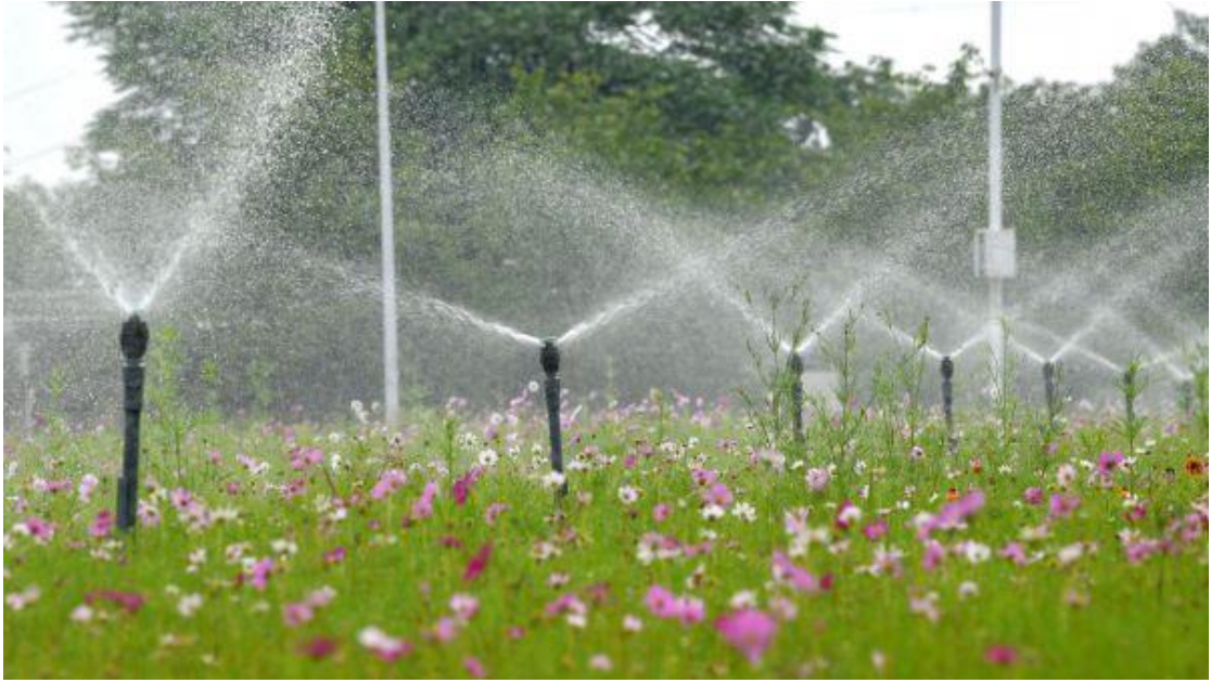
图 165：位于校园内的节水灌溉设备
